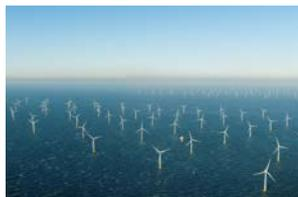
Ce projet se compose de 71 éoliennes en mer pour une puissance totale de ~500 MW.<sup>(4)</sup>
